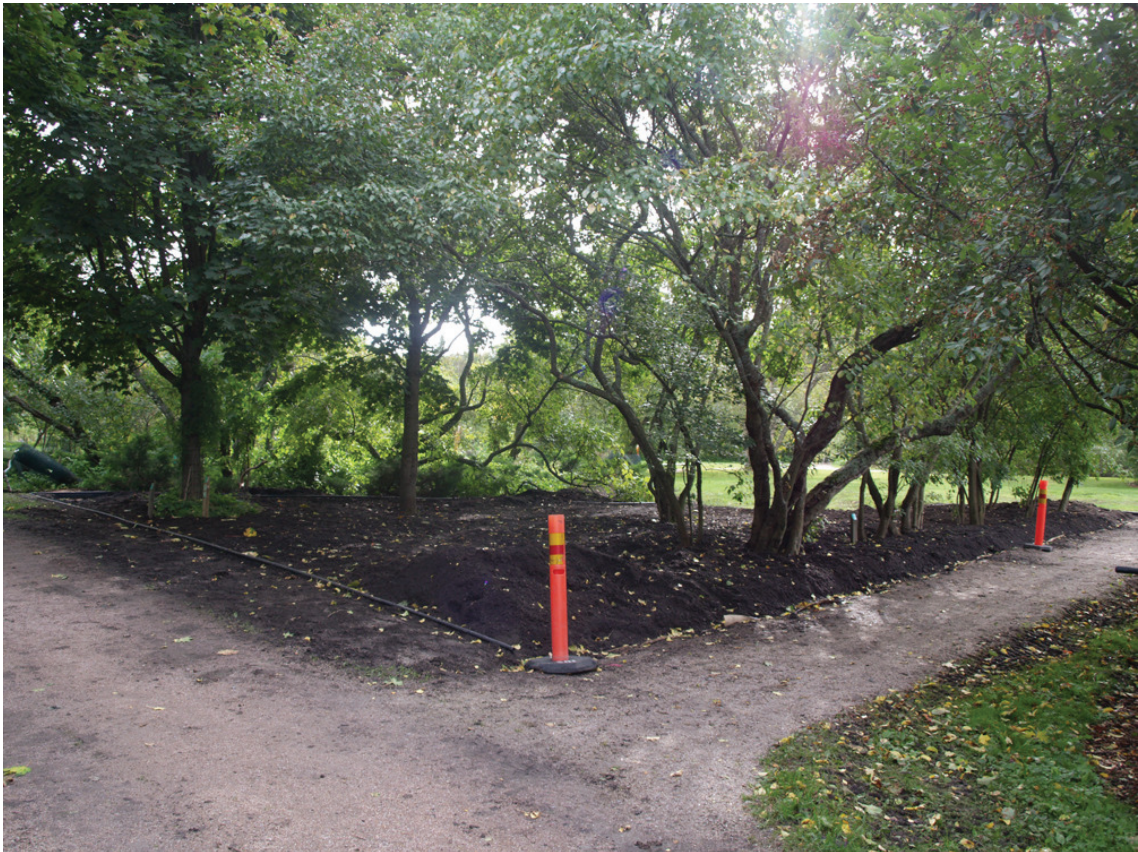
Kuva 30. Istutusalue kasvialustan levittämisen jälkeen syyskuun lopussa.
