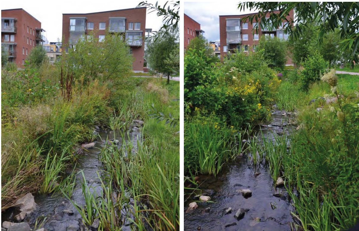
Kuva 18. Luontaisesti kasvittuneen suoran kivetyn uoman kasvillisuus ei muuttunut merkittävästi vuosien 2015 (vasemmalla) ja 2018 välillä. Selvin muutos on pajujen määrässä ja koossa. Kuva: S. Juhanoja
