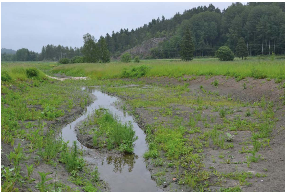
Kuva 47. Uomaan rakennettiin patoja ja levennyksiä. Kuva otettu 27.6.2016. Kuva: S. Juhanoja
