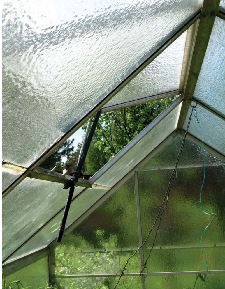
Tuuletusautomaatiikan avulla pieni kasvihuone ei kuumene liikaa kesähelteellä.
